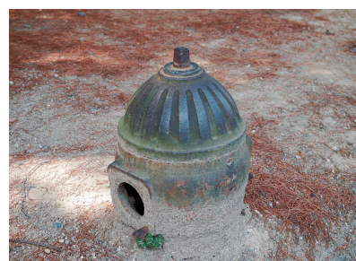
日本大学東北高等学校2号館前に残る海軍時代の消火栓
